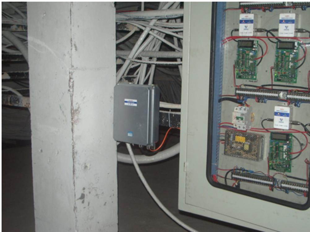
安装于现场的数据采集服务器（右侧是在线监测系统控制柜）
